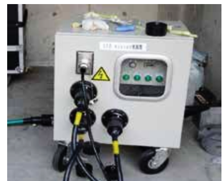
Bảng quảng cáo sân vận động Stadium advertisement signboard (distribution board)
